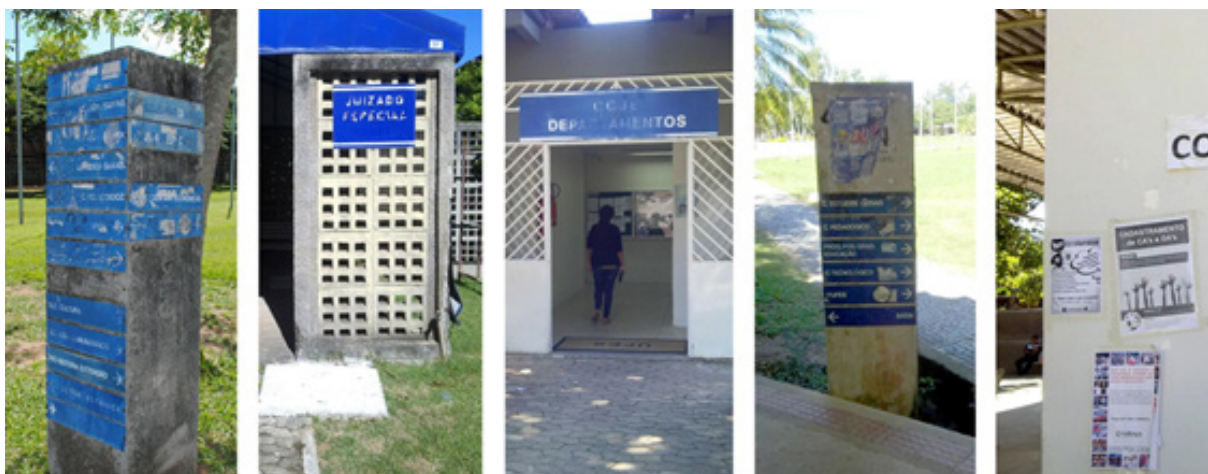
Figura 2 Totens de concreto, placas identificadoras e cartazes. É possível observar o estado de deterioração de grande parte das peças ao longo do campus, bem como a apropriação desordenada pela comunidade.
