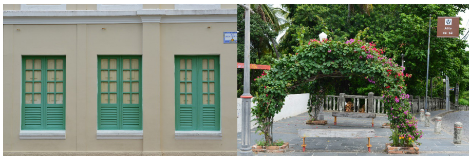
Figura 2 e 3 Na sequência: Janelas na fachada da Academia Santa Gertrudes e Mirante ao lado da Igreja da Misericórdia.
