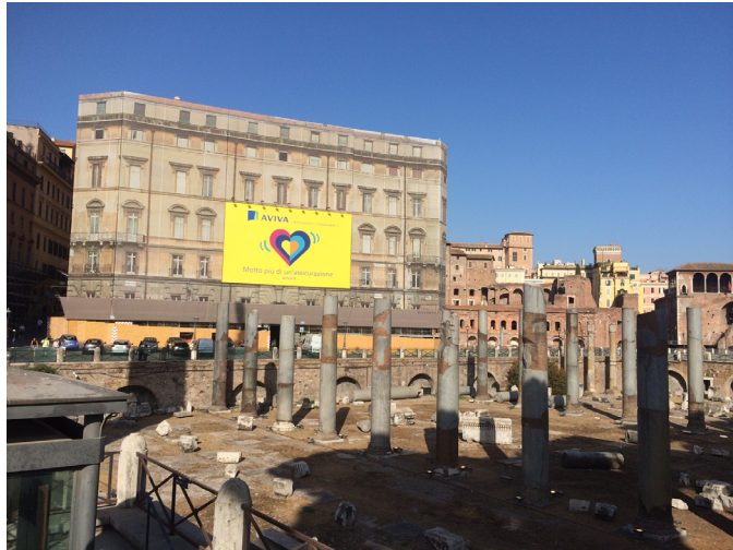
Figura 4 Anúncio em tela de obra, fachada impressa sobre a tela da obra. Autor: Vanessa Casarin, 2017.
